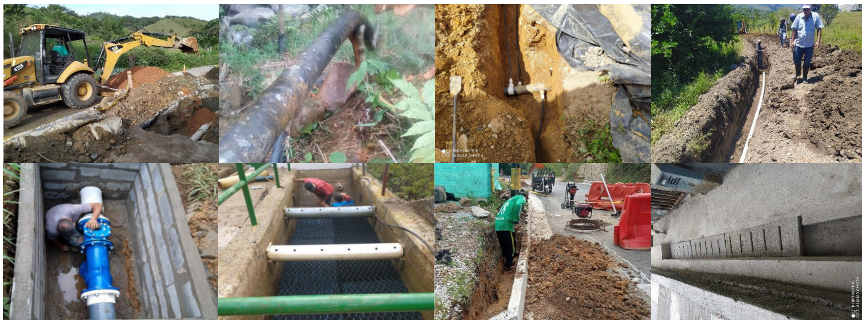
Obras de Alcantarillado
