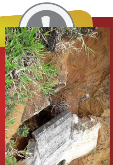
Cuneta a la vuelta de la estación de gas...
