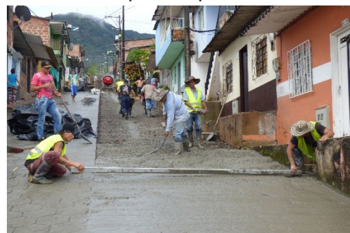
Proceso de pavimentación
