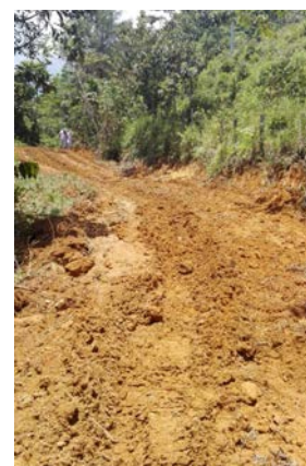
Estado de los caminos luego de la intervención
