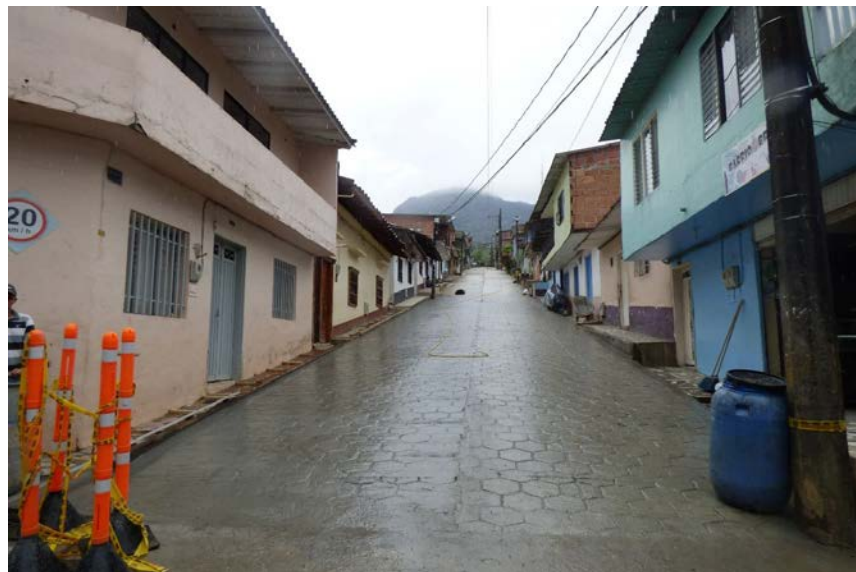
Aspecto de la calle 20 pavimentada.
