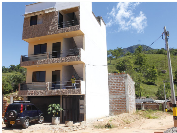
Edificio Sector Belén.
