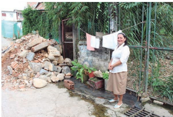
Aguas negras en la vía pública, sector el vivero
