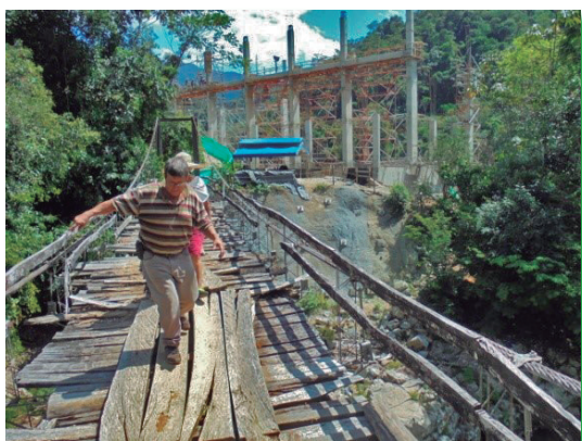
Puente La Víbora sobre el río Calderas, vereda El Pescao
