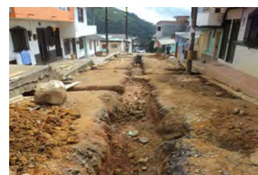
Reposición alcantarillado
