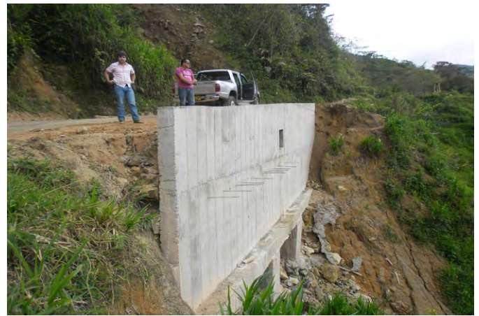
Recuperación Vía San Luis- Choco
