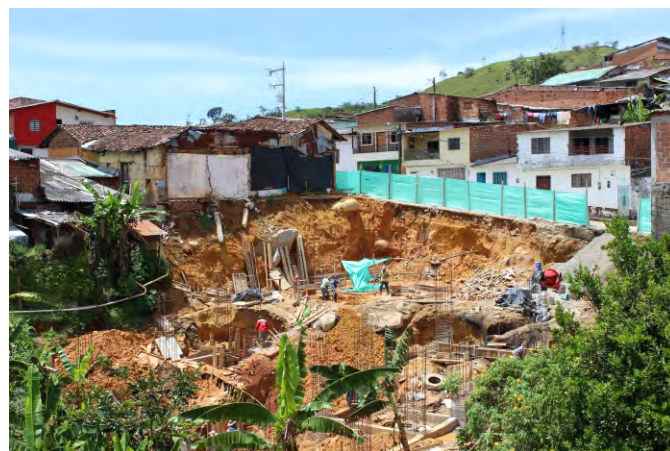
Urbanización en construcción
