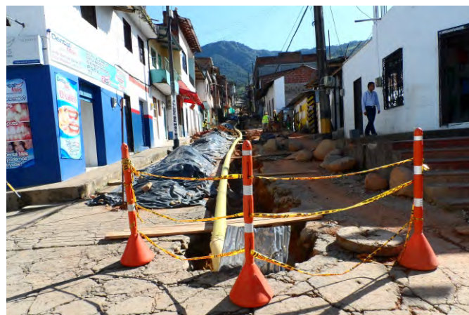
Pavimentación y Reposición de Alcantarillado
